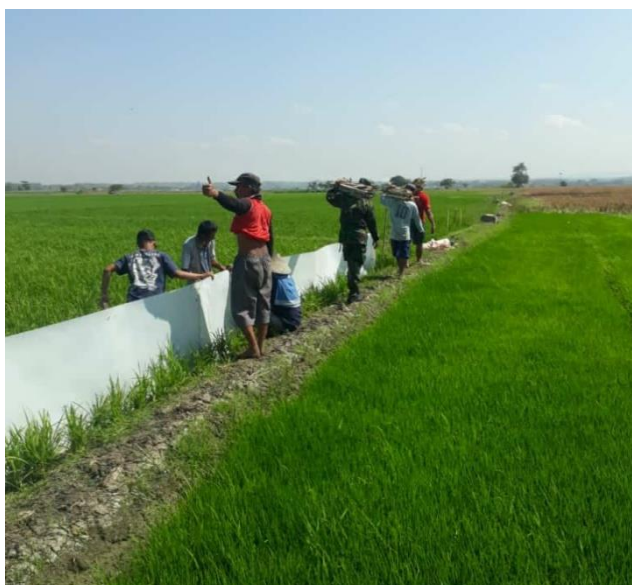
Gambar 4. Gotong Royong Pemasangan Fiber
